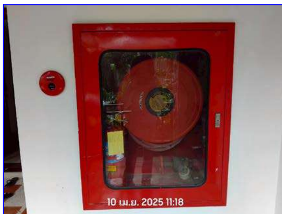
รูปที่ 2.20 ชุดดับเพลิง และถังดับเพลิงชนิดมือถือ
