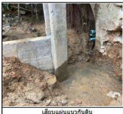
เตรียมพื้นที่เสียบแผ่น
